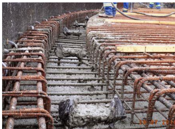
Figura 21 - Primeira etapa de concretagem para a consolidação dos chumbadores
