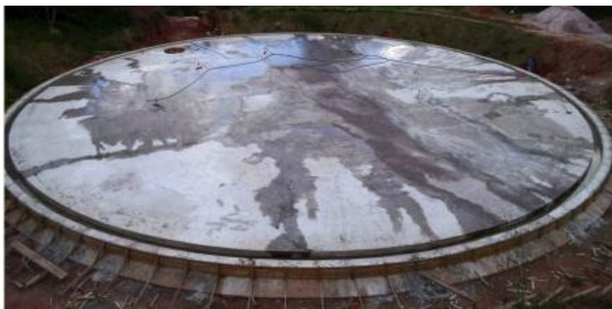
Figura 10 - Laje de fundo executada com canaleta (0,30m x 0,40m - PxL)
