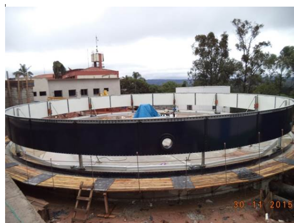
Figura 8 – Plataforma de trabalho montada
