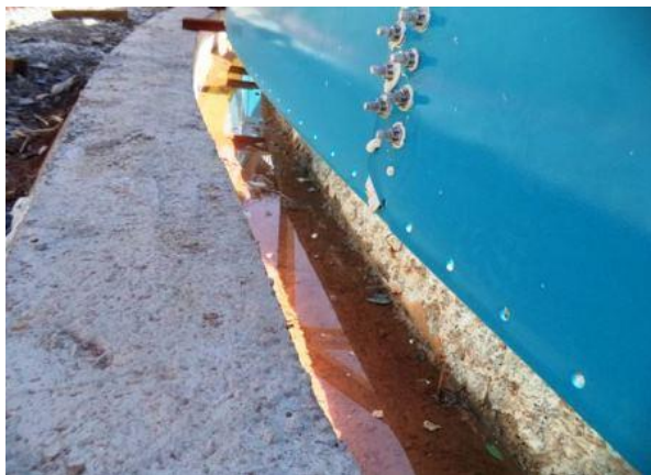
Figura 14 – Dificuldade: obter nivelamento da canaleta
