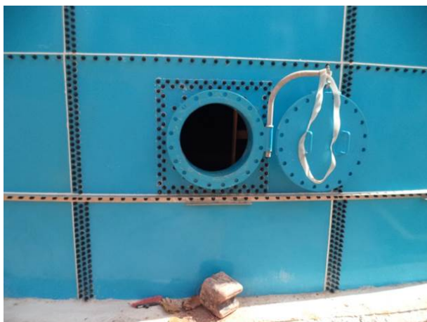
Figura 26 – Tanque iniciado com chapa inteira, em canaleta
