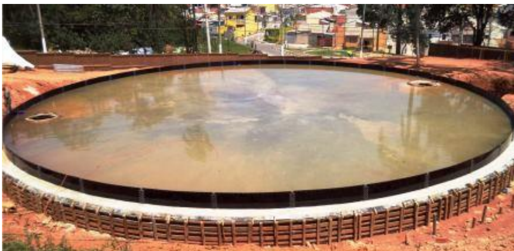
Figura 18 - A montagem prévia do primeiro anel de chapas possibilita concretagem única e favorece a cura da laje com lâmina d'água
