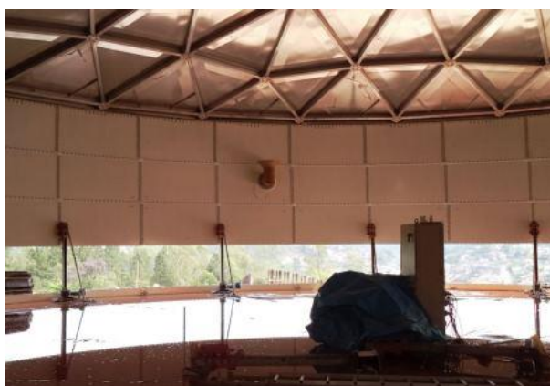
Figura 29 – Tulipa do extravasor instalada durante a montagem do costado
