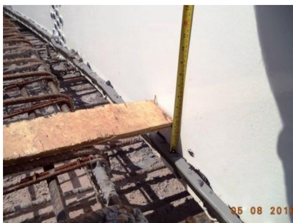
Figura 22 - Fixação da fita hidroexpansiva garantindo seu cobrimento mínimo
