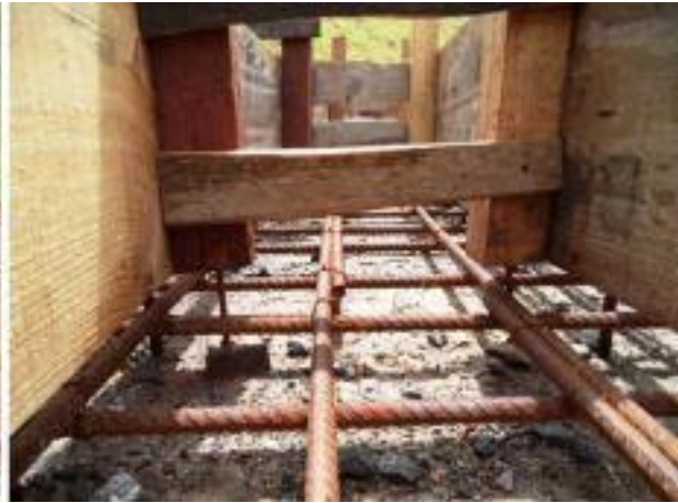
Figuras 12 e 13 – Dificuldade: execução das formas para concretagem única da laje de fundo com canaleta
