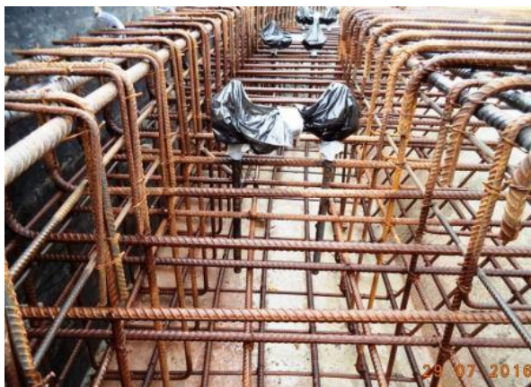
Figura 20 - Fixação dos chumbadores devidamente protegidos
