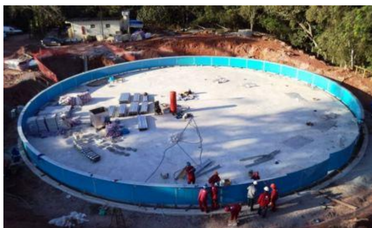
Figura 11 – Facilita a separação das fases de obras Civis e Montagem mecânica do tanque
