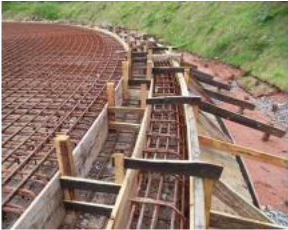
Figuras 12 e 13 – Dificuldade: execução das formas para concretagem única da laje de fundo com canaleta
